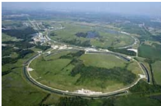
Figura 1.9: Vista aérea del Fermilab. El anillo en primer plano es el Inyector Principal y el anillo posterior es el Tevatrón, acelerador donde se descubrió el quark top .
